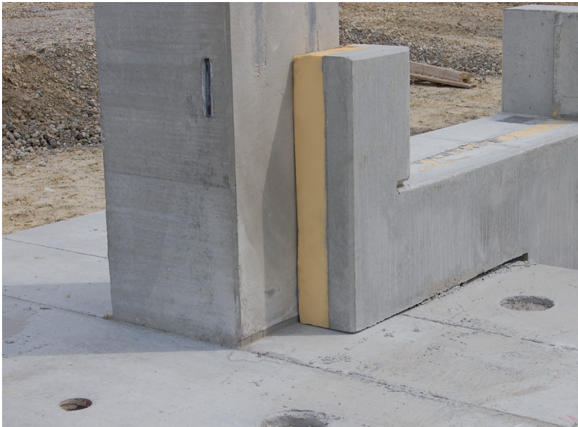
Für den Industriehallenbau: ein Betonelement mit integrierter PU-Dämmung.
