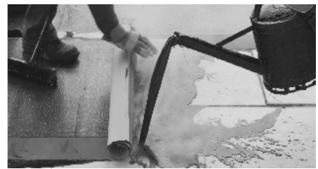
Verlegung in Heißbitumen
