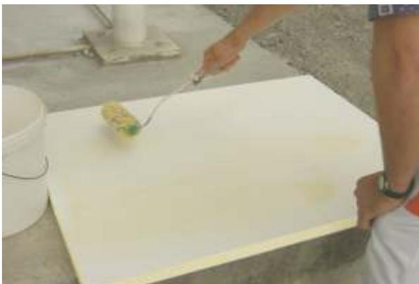
*Versehen mit einer geeigneten Haftbrücke wie beispielsweise epasit pk, die flächig aufgetragen wird, läßt sich die puren Kellerdeckendämmung problemlos mit Plattenklebern wie epatherm etk auch auf mineralischen Untergründen (Massivdecke) verkleben.*
