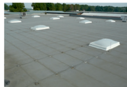
9. ábra: tető felülvilágítókkal
