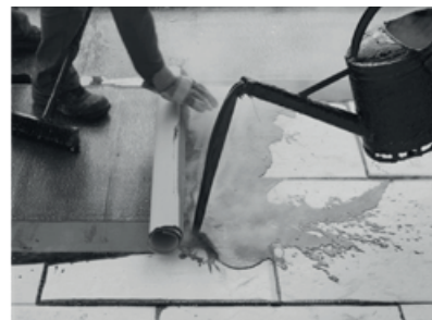
Olvasztott bitumenbe ágyazás
