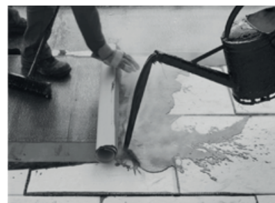
Pokládka do horkého asfaltu
