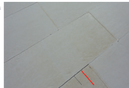
Obr. 6: Příklad sparové netěsnosti
