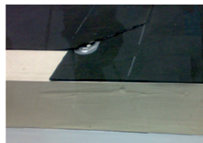
Obr. 8: přesah dvou vrestev hydroizolace+kotva
