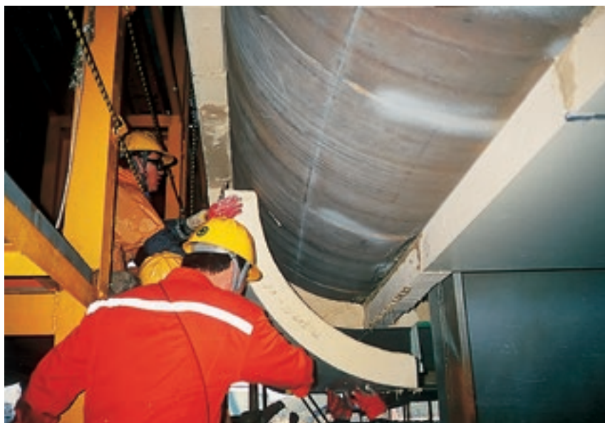
Coquilles pour tuyaux en matériau d'isolation haute performance PIR de puren ® – L'isolation parfaite à des températures extrêmement élevées et basses.
