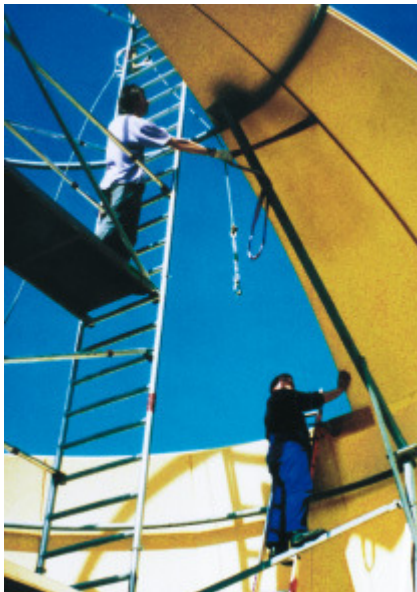
Speziell geformte Platten werden hier zur Dämmung einer Kuppel verarbeitet.
