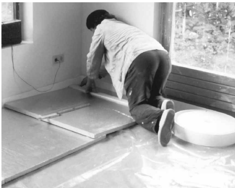
puren GA Dämmplatten als hitzebeständige Schicht unter Gußasphalt.
