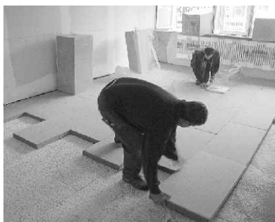
puren GA Dämmplatten als hitzebeständige Schicht unter Gußasphalt.
